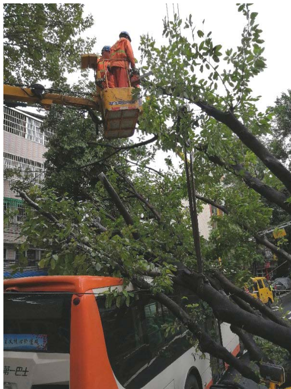
广州惠福西路 公交车倒树压车，造成变压器着火
