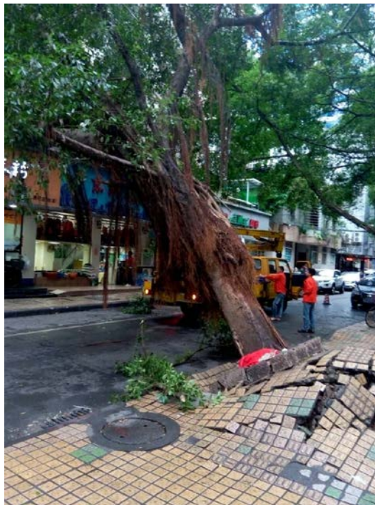
倒伏树木对市政 设施的破坏
