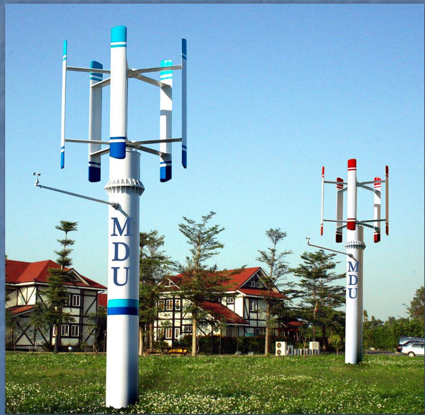
明道大學垂直軸 4kW 風力發電機
