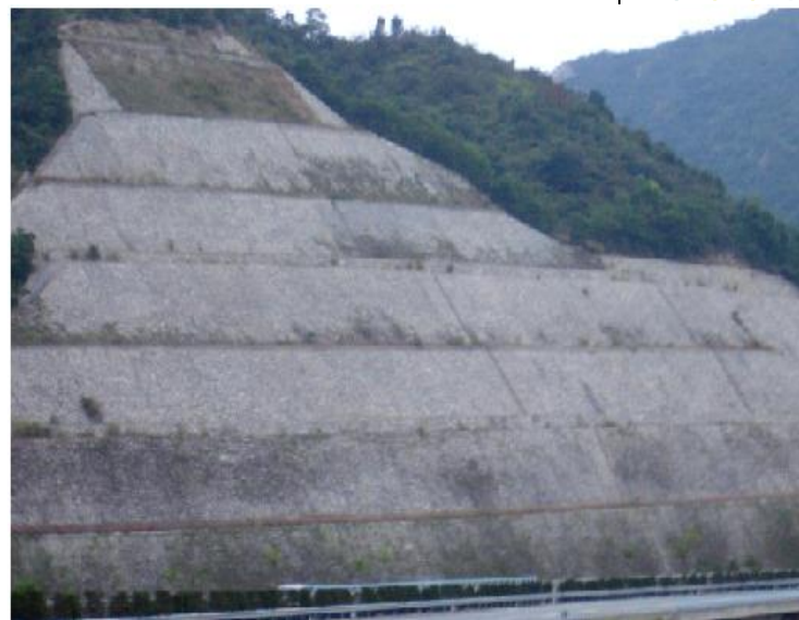
工程防护：浆砌石挡墙
