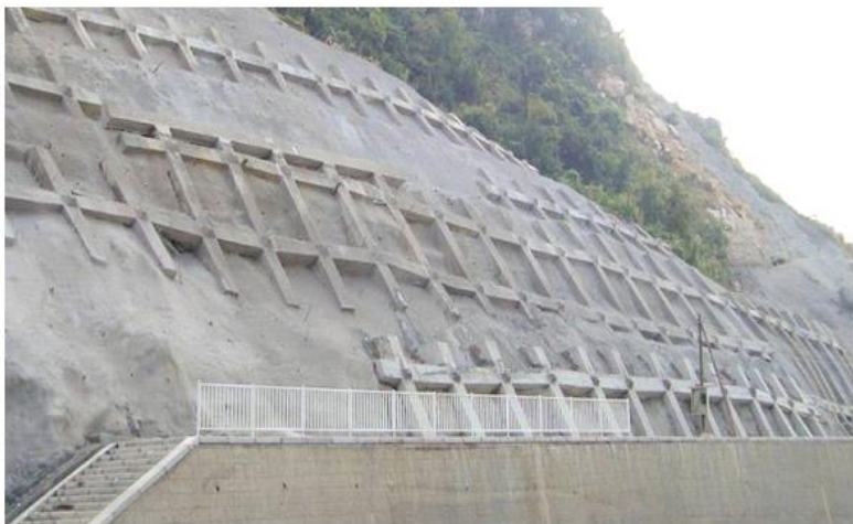
工程防护：格构梁+喷砼
