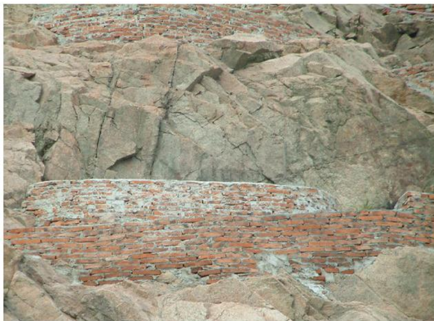
■微地形工法（燕巢法/鱼鳞坑法）现场图
